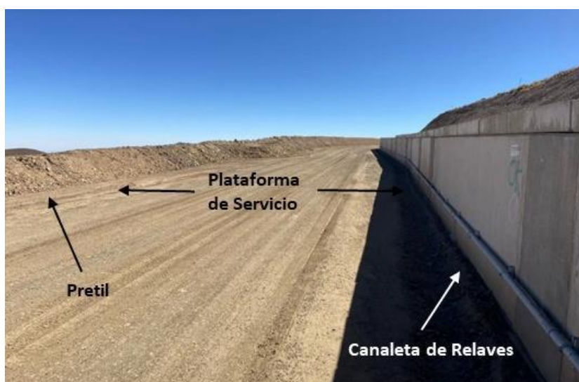
Figura 8: Fotografía "Pretil en borde de plataforma de canaleta de relaves"
