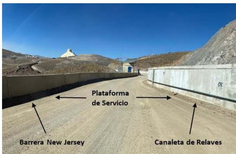
Figura 8: Fotografía "Pretil en borde de plataforma de canaleta de relaves"
